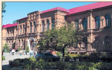
Третій корпус після ремонту
